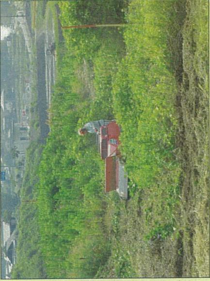
点在現場間で重機を移動（一般道通行のため、移動のたびにトレーラーに積込・積卸。積算上は共通仮設費率に含まれている。）
