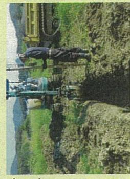
○掘削～暗渠管布設～被覆材投入～埋戻の工程について、標準作業量をサイクルタイム(一連の作業を日単位で施工)に見直し。日標準作業量は、人力を施工である暗渠管布設により決定。
