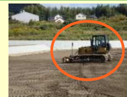
7t 湿地ブルドーザ
