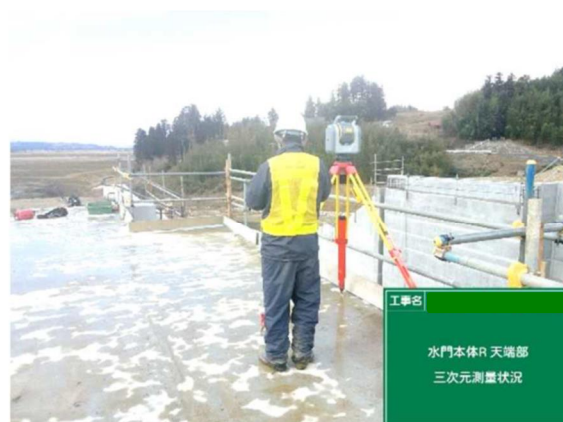
3D計測状況（壁上面）
