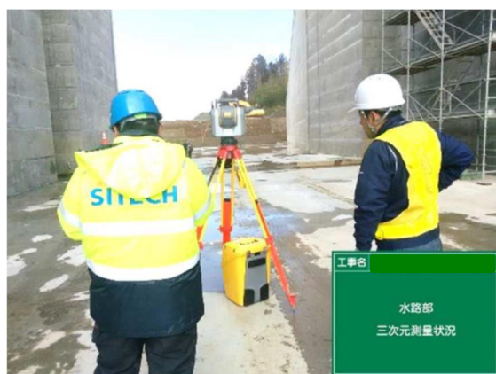
3D計測状況（壁側面）
