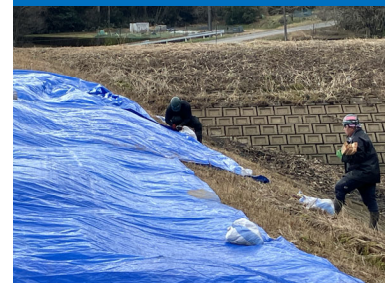
ブルーシートによるため池堤体の保護
