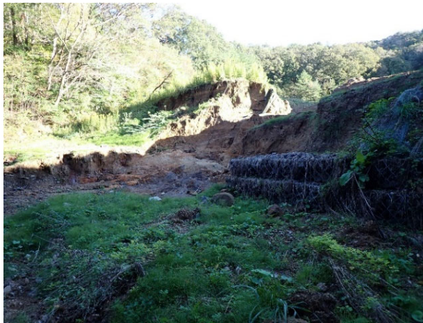
ため池の決壊(石川県輪島市)
