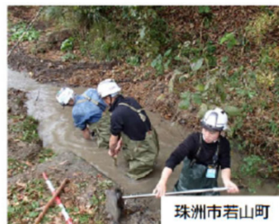
流木撤去完了
