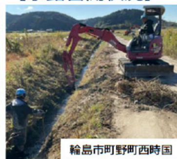
【水路啓開状況】
