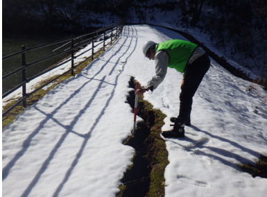
ため池堤体のひび割れの調査
