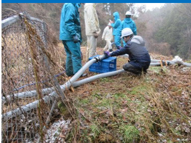
被災ため池に県土連所有の簡易排水施設を設置
