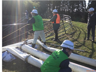
ポンプ排水によるため池の水位低下
