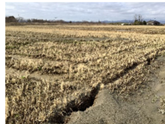
農地の亀裂(石川県内灘町)
