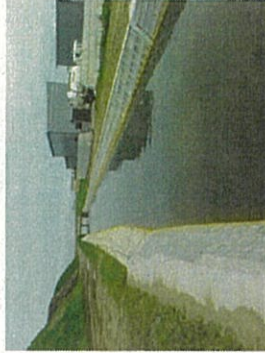
津波で損壊した排水路の復旧状況
